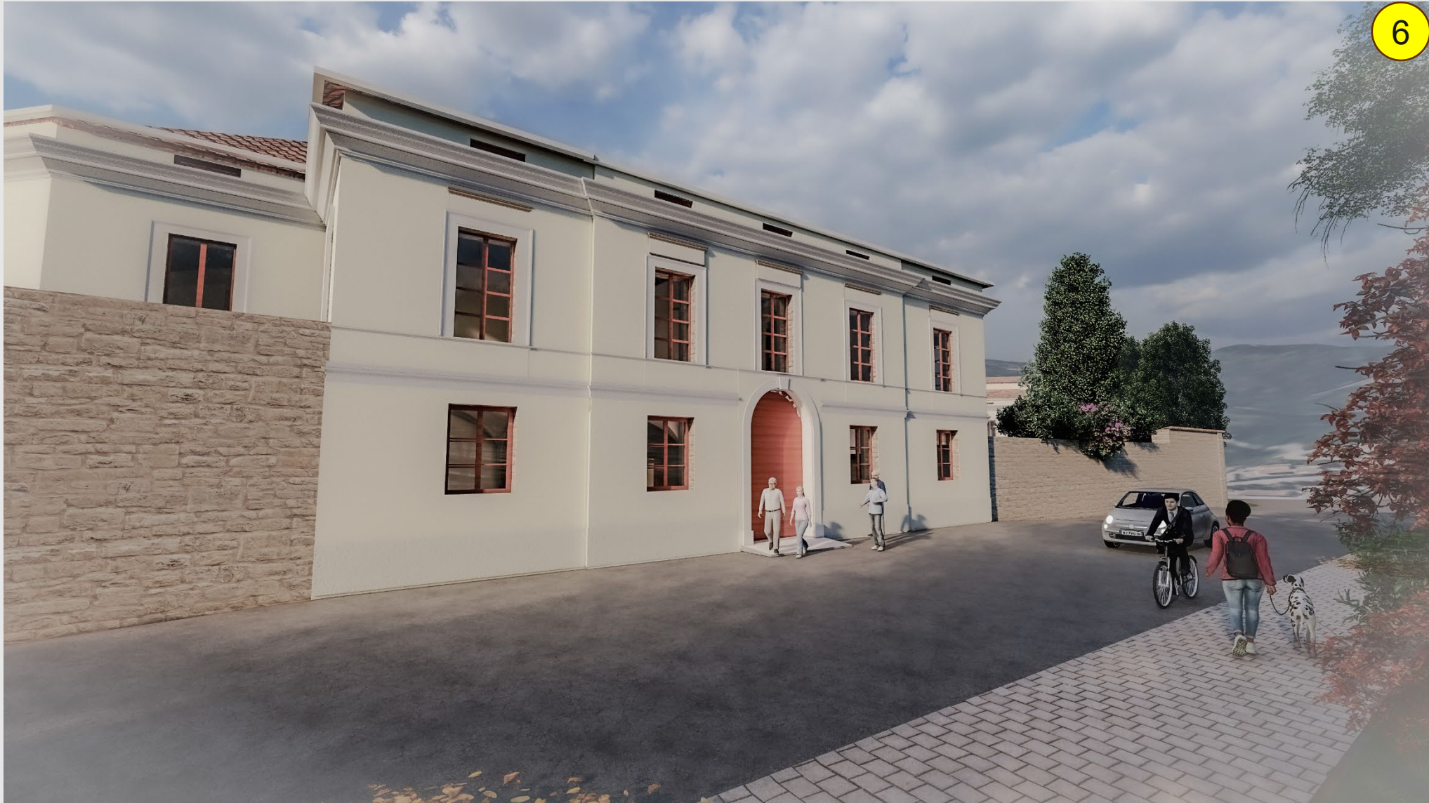
Ingresso su Viale Mazzini
