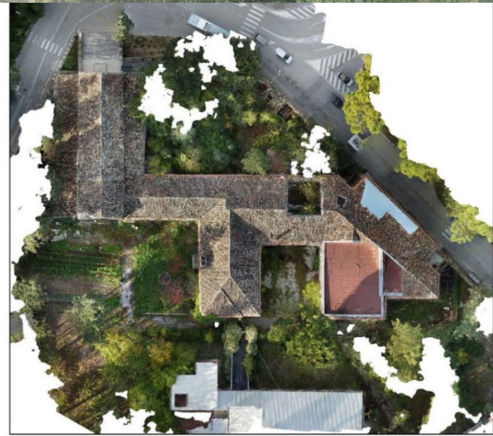
Rilievo copertura con drone
